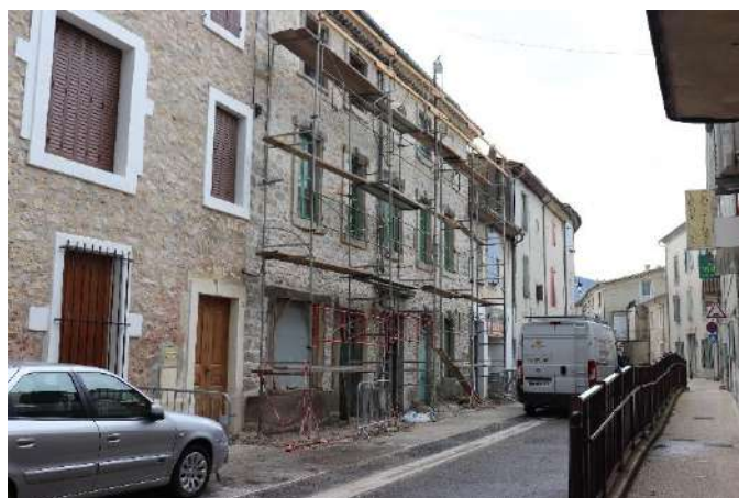
Figure 1 : Réhabilitation de logements en centre ancien - Quissac - Crédits : A'U 2020
