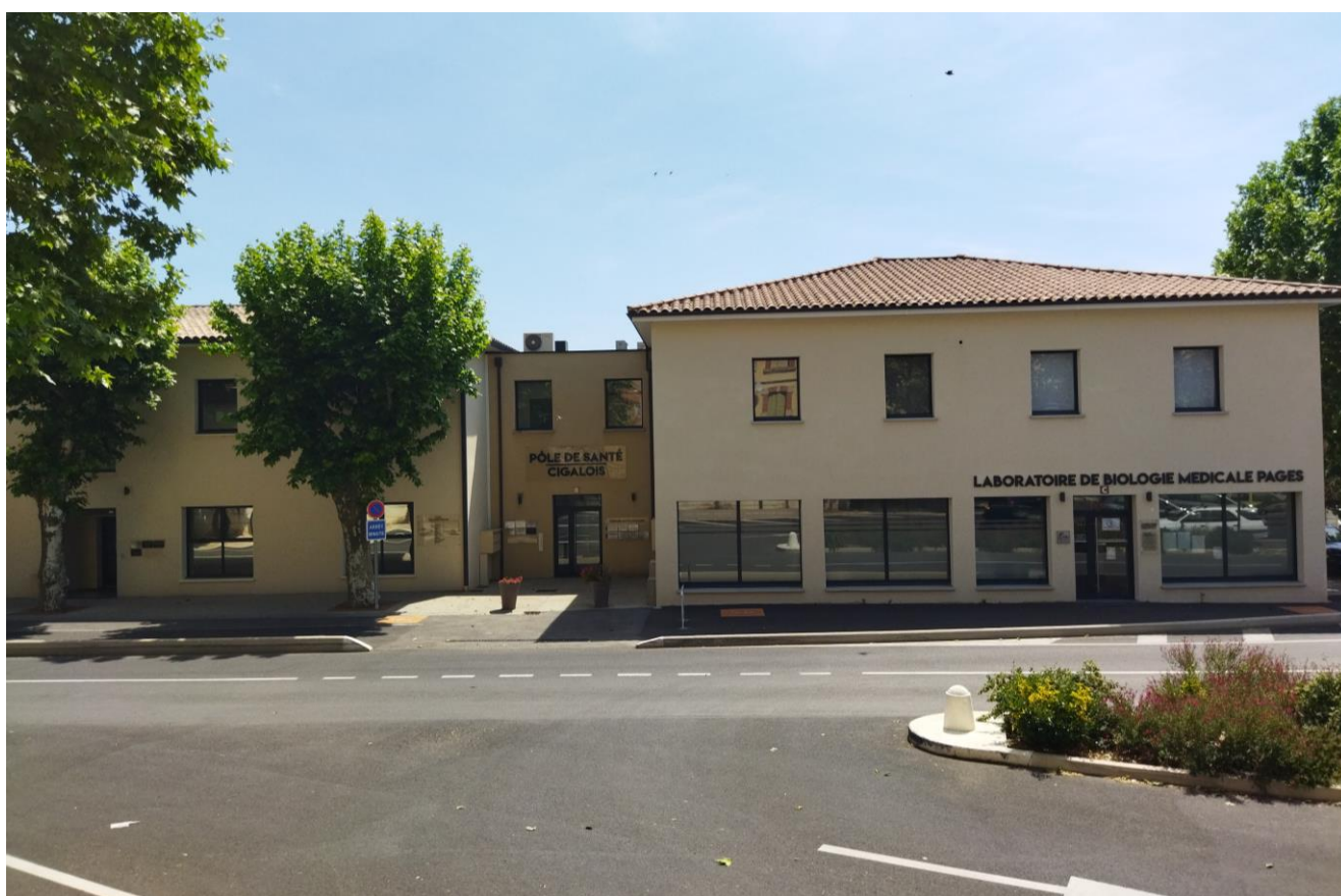
Requalification de la place Berthezène et création d'un pôle de santé
